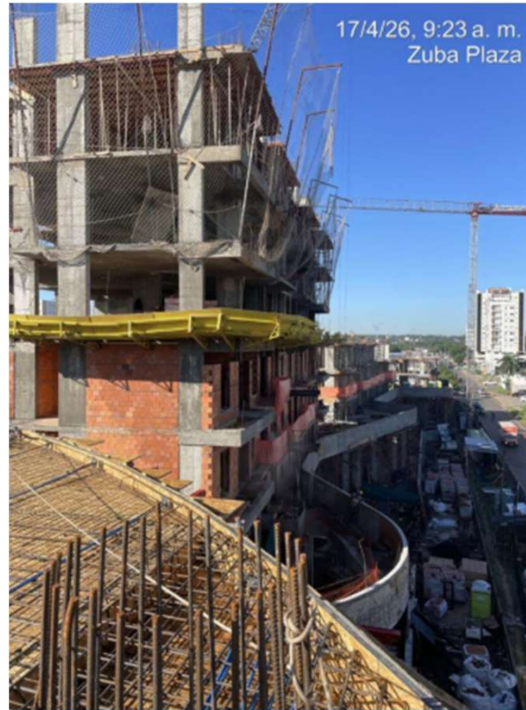
Cargamento de Pilares – Avance Encofrado y Cargamento Losa N3
